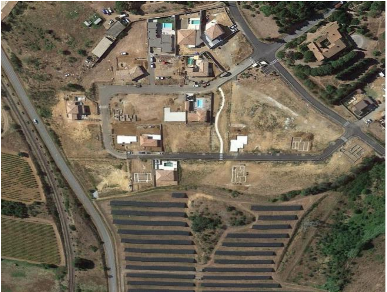
Vue aérienne de la centrale photovoltaïque en exploitation et du lotissement construit.
